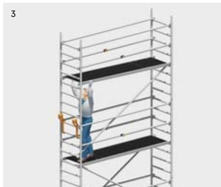
Diagonalen und Durchstiegsbrücke einsetzen.
