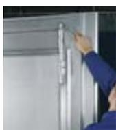
Den massiven Sechskantkopf mit Bohrspitze mit einem 27er Maulschlüssel fest unter dem Sturz arretieren,
