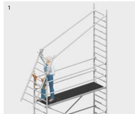
Aufstecken der ersten Standleiter. Anbringen der Uni Montagehaken und Positionierung der zweiten Standleiter zur Montage der Geländer.
